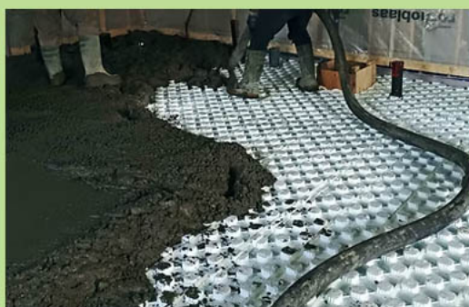
Coulage de la dalle de béton sur l'ISORAD V2 où sont ancrées les conduites en PEX du chauffage par rayonnement.
